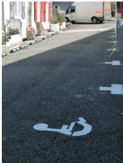
Mise en place des butées normalisées et traçage de la signalétique horizontale par les services techniques
